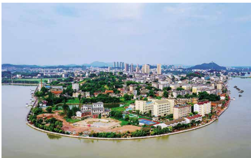
2020 年 7 月 20 日,被洪水围困的县城防洪墙及老城区,长河成为“悬河”
