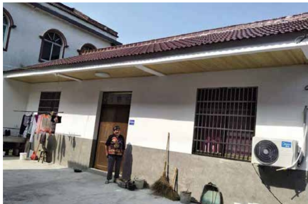
抓实危房改造。2018年,白梅乡孙畝村贫困户杨贤华住上改造后的新房 (县民生办/供)
