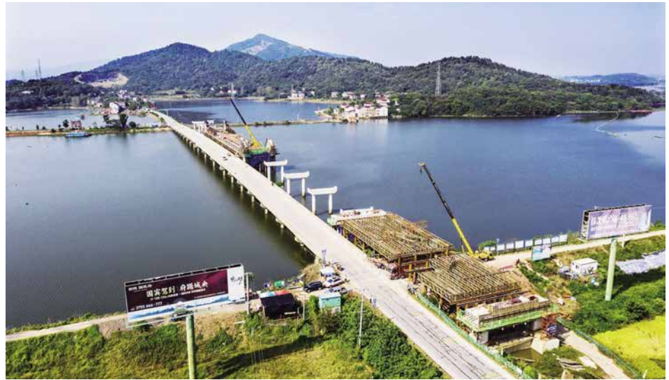
2020年9月28日,乌金渡桥新建工程正在施工 (汪华君/摄)
