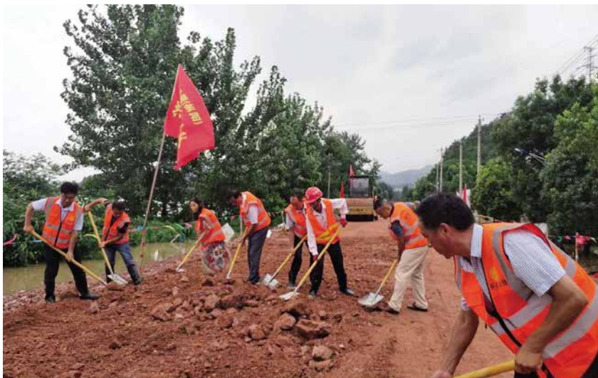
2020年7月21日,枞阳公路服务中心党员突击队在国道347长河段抢险 (黄言为/摄)
