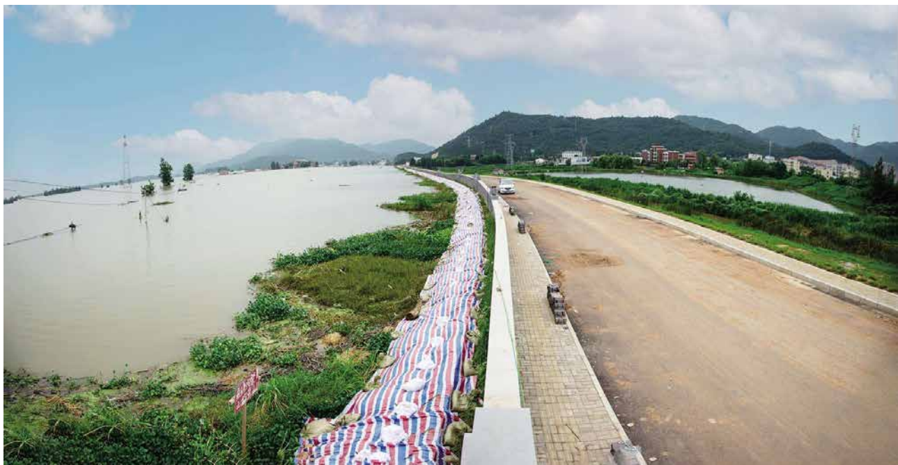
2020年7月25日,县城连城湖出口右岸新堤安然无恙,保障堤内(右侧)连城工业园区安全 (钱正义/摄)
