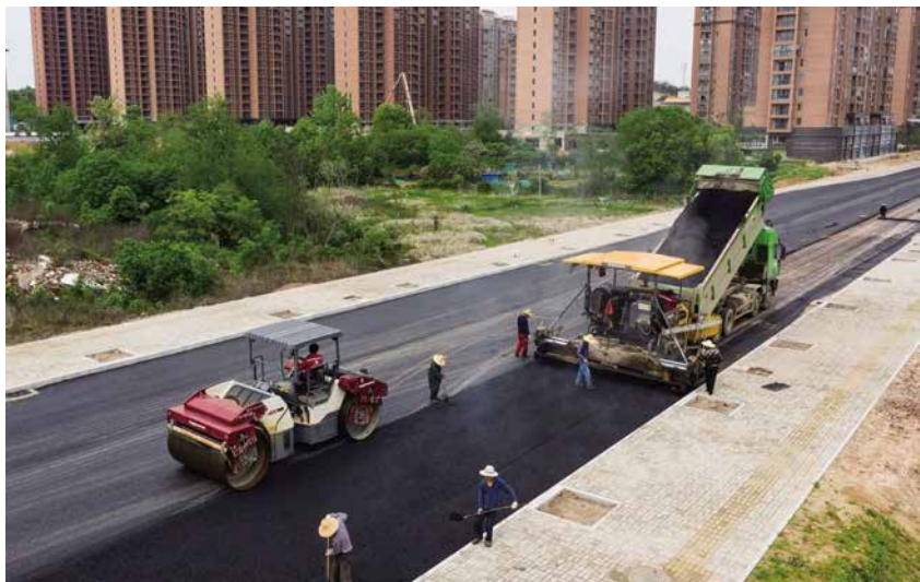
2020 年 4 月 23 日,县城区金坛路(二期)工程铺设柏油路面
