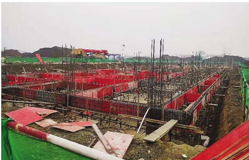
2020 年 12 月,安徽供销枞阳农产品综合物流产业园项目农批市场施工现场 (胡章满/摄)
