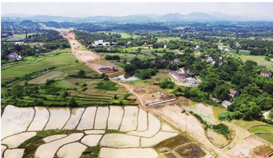
2020年6月5日,德上高速枞阳段土建工程正在紧张施工。该路线长21.85千米,途经浮山、会官、义津、钱桥、麒麟等乡镇
