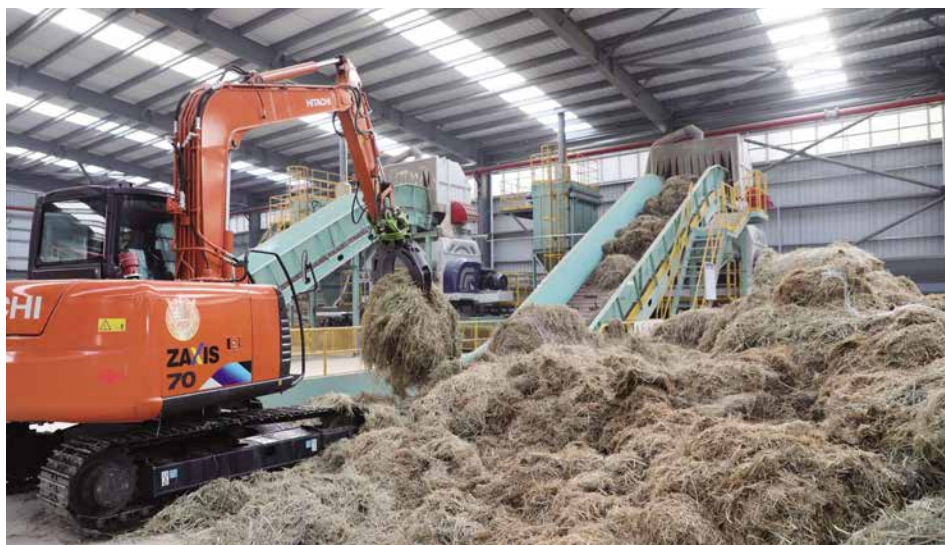
2020年9月，安徽枞阳海螺水泥股份有限公司建设的国内首条生物质替代燃料系统试生产，每2吨秸秆可替代近1吨标准煤 (王章志/摄)
