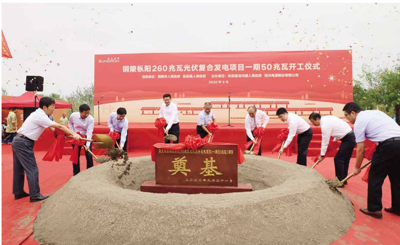
2020年9月21日,枞阳县260兆瓦光伏复合发电项目一期50兆瓦工程开工
