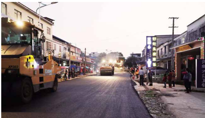
2020年11月8日,义津镇到钱桥镇的公路改造施工现场
