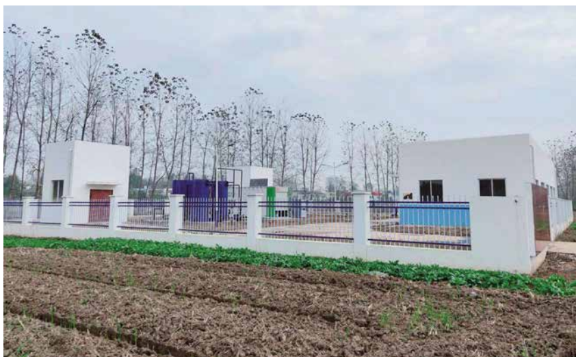
长沙乡污水处理站
