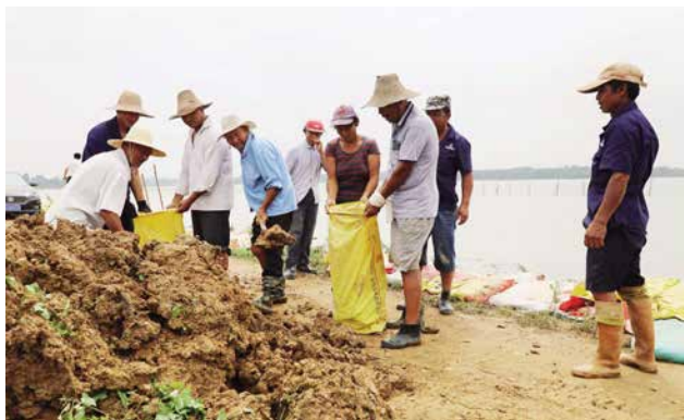
2020年7月6日12时起,枞阳县进入紧急防汛期。图为7月7日,麒麟镇团结圩加固堤防 (王章志/摄)
