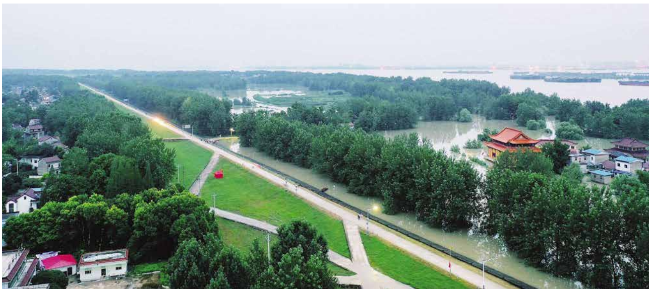
2020年7月,长江枞阳段遭遇特大洪水。图为7月14日,汤沟镇桂坝江外滩被淹情况 (汪启明/摄)
