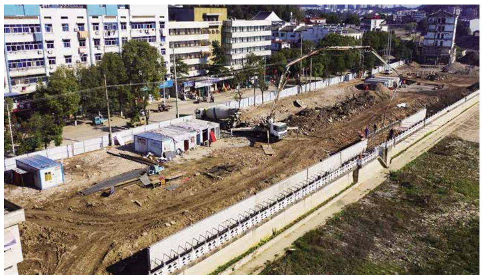
2020年12月16日,县城防洪安保防洪墙加固改造工程正在施工 (汪华君/摄)
