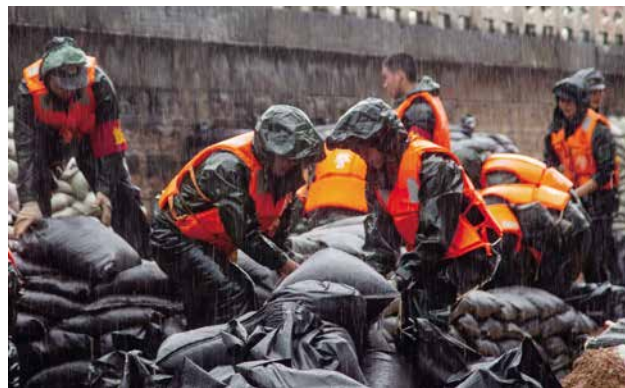
2020年7月15日,武警安徽总队蚌埠支队官兵冒雨加高加固城关防洪墙 (黄向华/摄)
