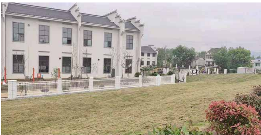
民生工程项目——建成后的永登圩永登二站(排涝站) (县财政局 / 供)
