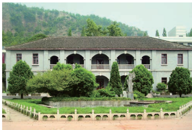
浮山中学中大楼
