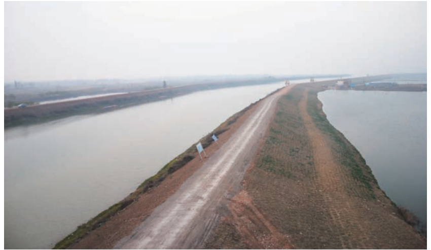
实施中小河流治理项目的汤沟镇大稻圩圩堤 (县水利局 / 供)
