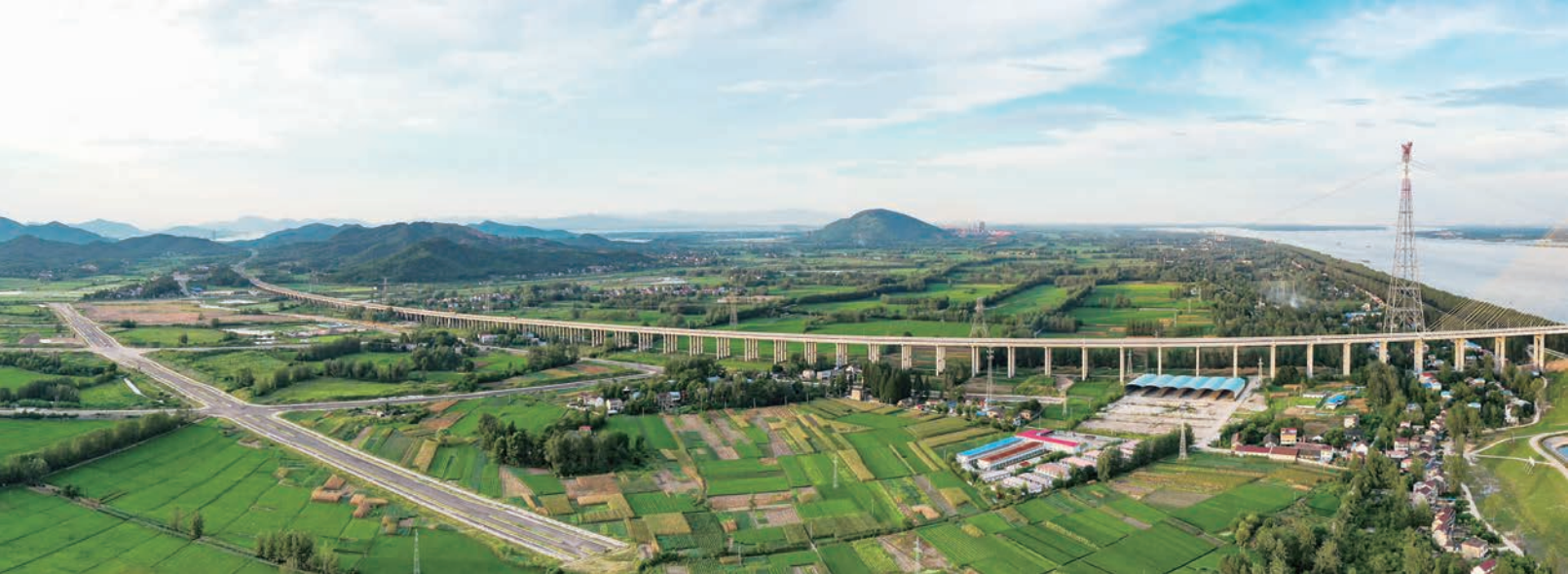
池州长江公路大桥全景图
