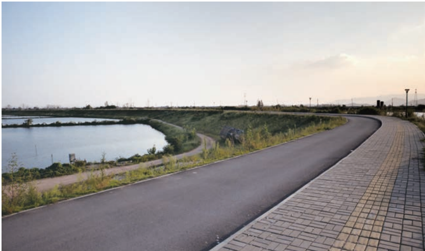
加固后的枞阳镇五圩大堤 (胡学东 / 摄)
