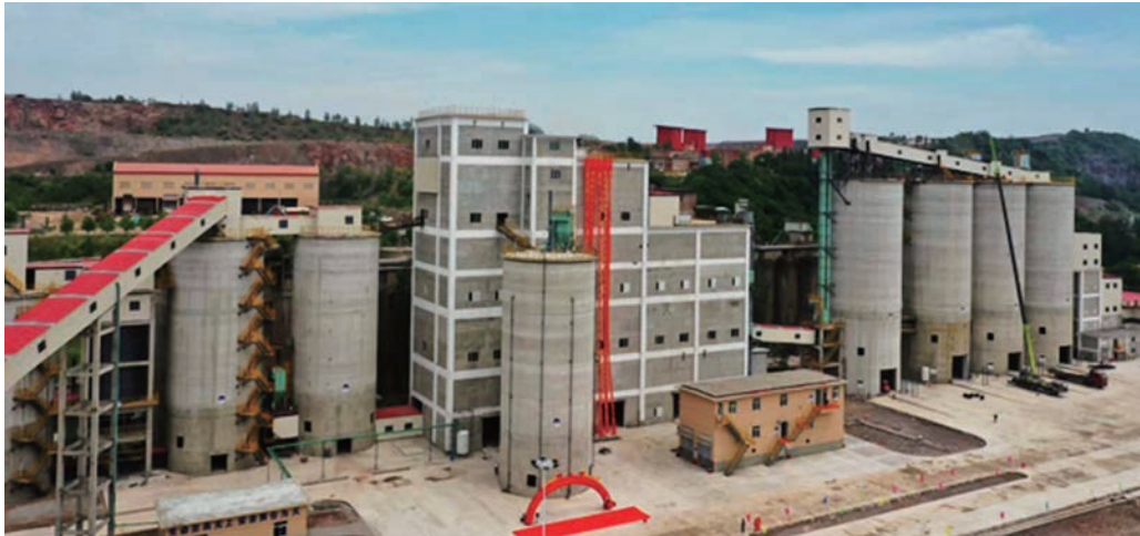
2019年5月29日,安徽枞阳海螺水泥股份有限公司110万吨水泥磨项目竣工投产,年产水泥由40万吨提升至110万吨 (县大水泥办/供)
