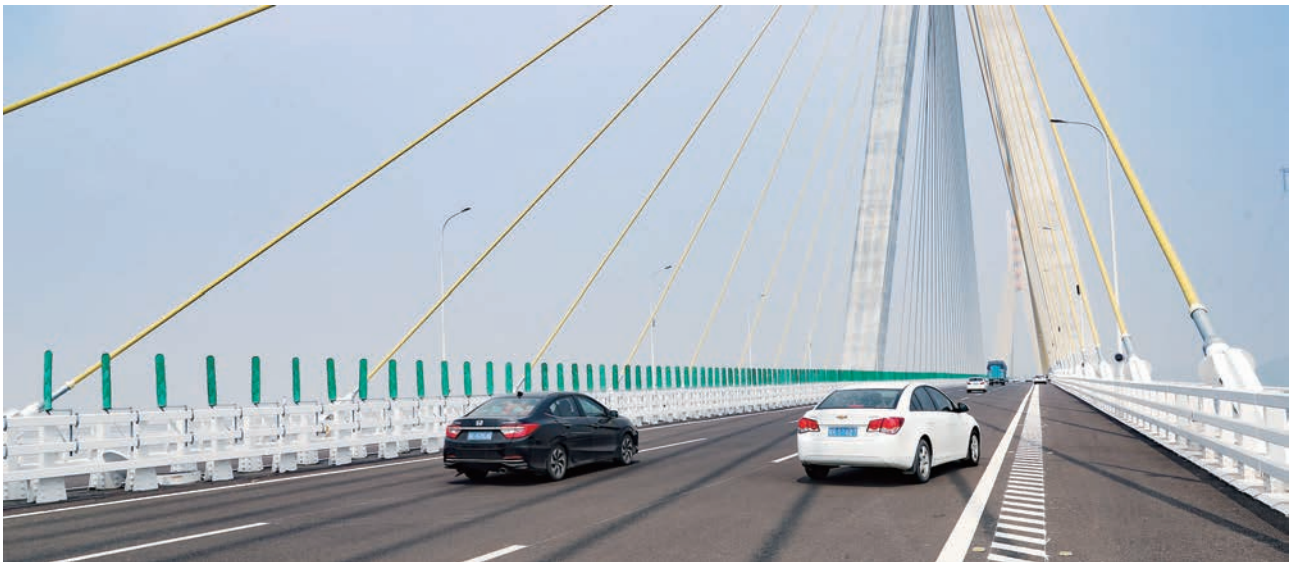
2019年8月31日,车辆行驶在刚开通的池州长江公路大桥上 (王章志 / 摄)
