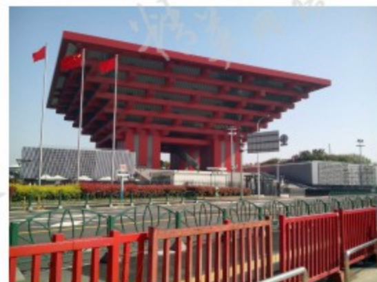
联丰冷却塔上海世博会项目
