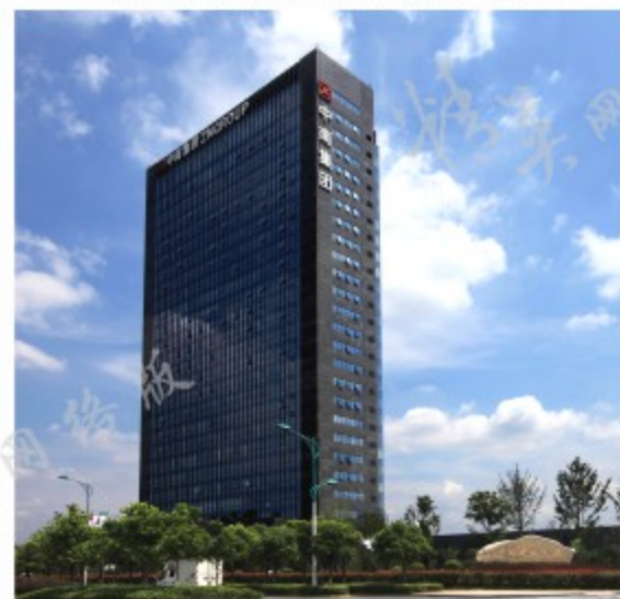
中南集团总部大楼
