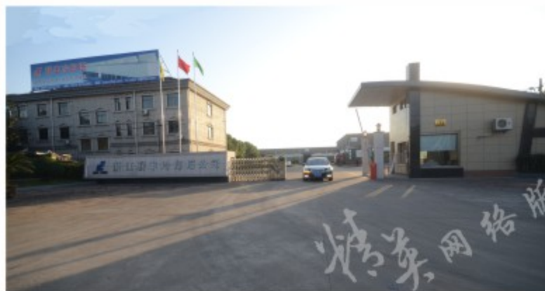
浙江联丰冷却塔公司
